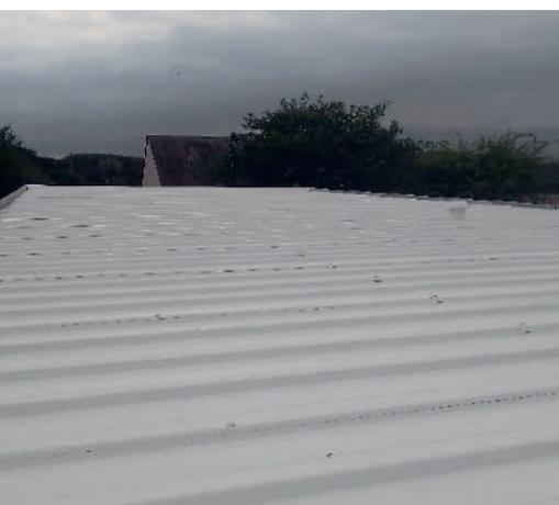
Après la climatisation installée il y a quelques mois, la toiture a été recouverte d'une peinture blanche destinée à rafraîchir le bâtiment et à générer des économies d'énergie.
